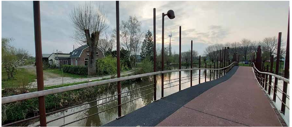
De nieuwe Hoonbrug met daarop het Jaagpad, op het bedrijventerrein De Honen in het najaar van 2021.
